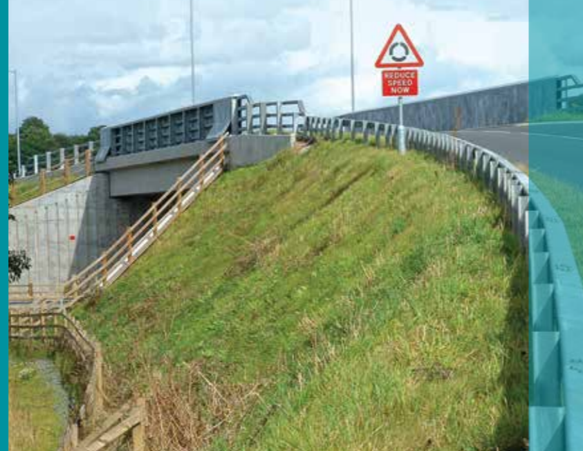
Системы усиления откосов позволяют сократить сроки строительства и минимизировать время остановки движения.
