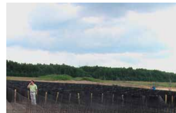
Строительство КАД. (Санкт-Петербург)
