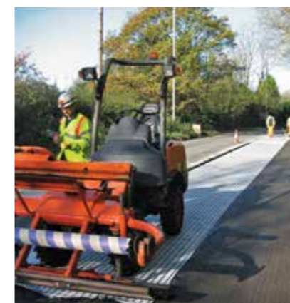
Материал AR-GN надежно приклеивается к нижележащему слою.
