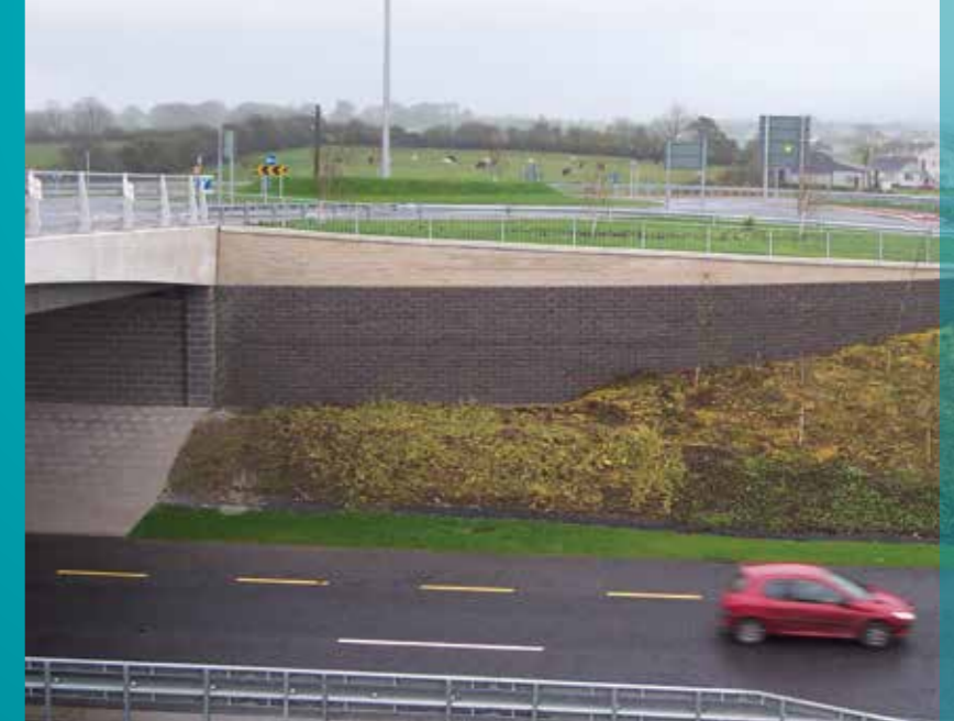
Система Тенсар — для отделки поверхности устоя моста использована комбинация из цветных модульных блоков.
