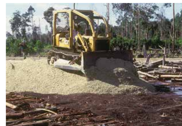
Строительство дороги с применением гибкого ростверка Тенсар на торфяках. (Индонезия)
