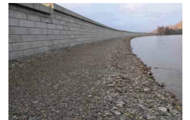
Система Тенсар с облицовкой из гидроблоков, возведенная в морской гавани, устойчива к агрессивным условиям прибрежной зоны.
