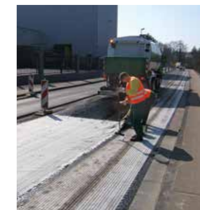
Технология укладки Glasstex™ проста, полотна укладываются внахлест.
