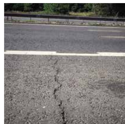
Колееобразование, усталостное и отраженное растрескивание — основные виды деформации дорожного покрытия.
