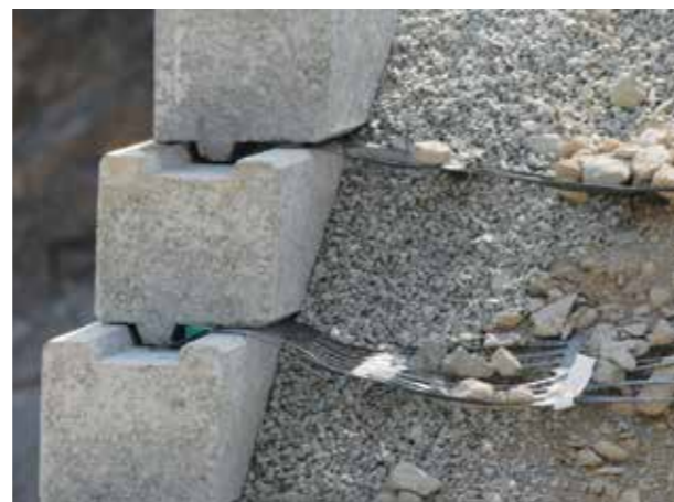
Высокая прочность соединения георешетки с элементами облицовки — характерная особенность всех армогрунтовых систем Тенсар.
