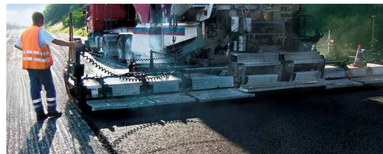
Слой асфальтобетона укладывается непосредственно на георешетку AR-GN.
