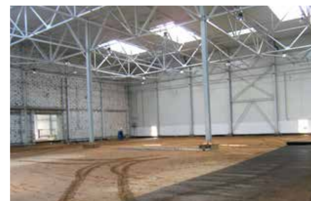
Гибкий ростверк Тенсар, поддерживающий плиты пола первого этажа здания завода. (Орехово-Зуево)
