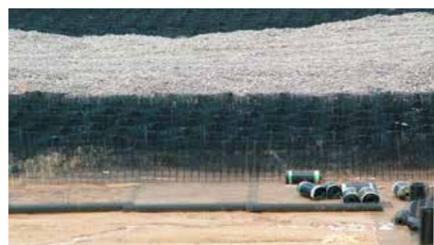
Применение системы сотового геоматраса Тенсар в условиях неоднородных грунтов.
