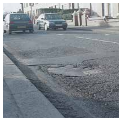
Колееобразование, усталостное и отраженное растрескивание — основные виды деформации дорожного покрытия.
