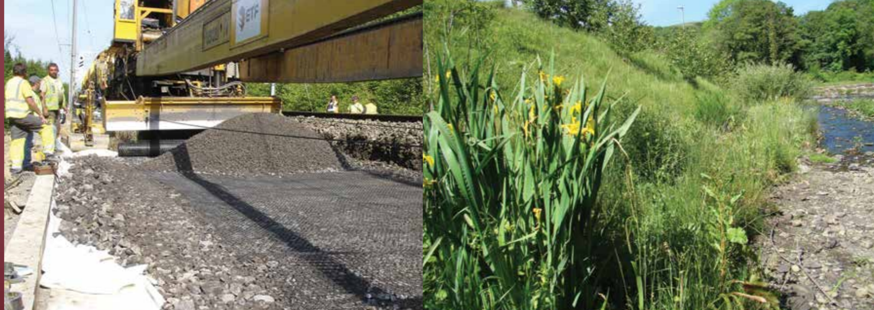
Укладка георешетки Тенсар TriAx® в подбалластном слое для повышения несущей способности
