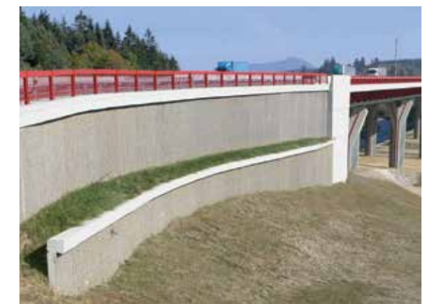
В качестве отделки на фасадах могут быть использованы панели как заводского изготовления, так и отлитые на месте.
