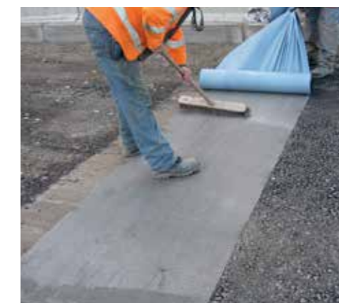
Glasstex™ Patch™ 880 прикрепляется на практически любую монолитную поверхность с помощью адгезивной составляющей композита.
